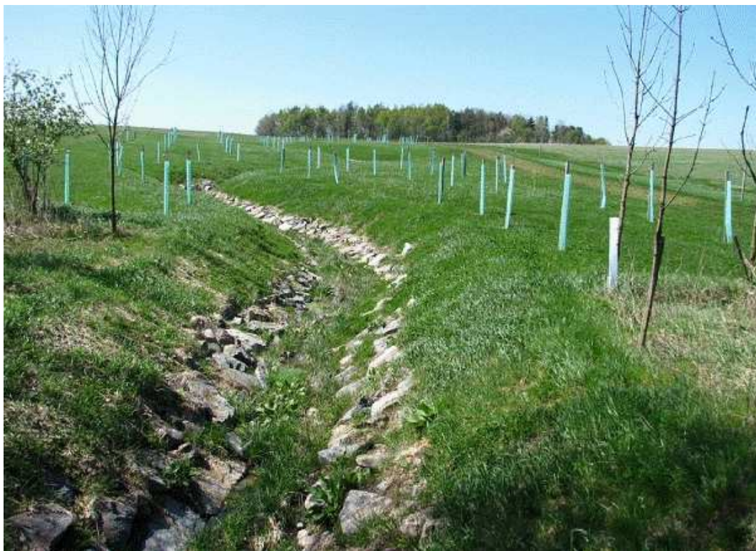
Obr. 4. Svodný příkop opevněný kamenem
